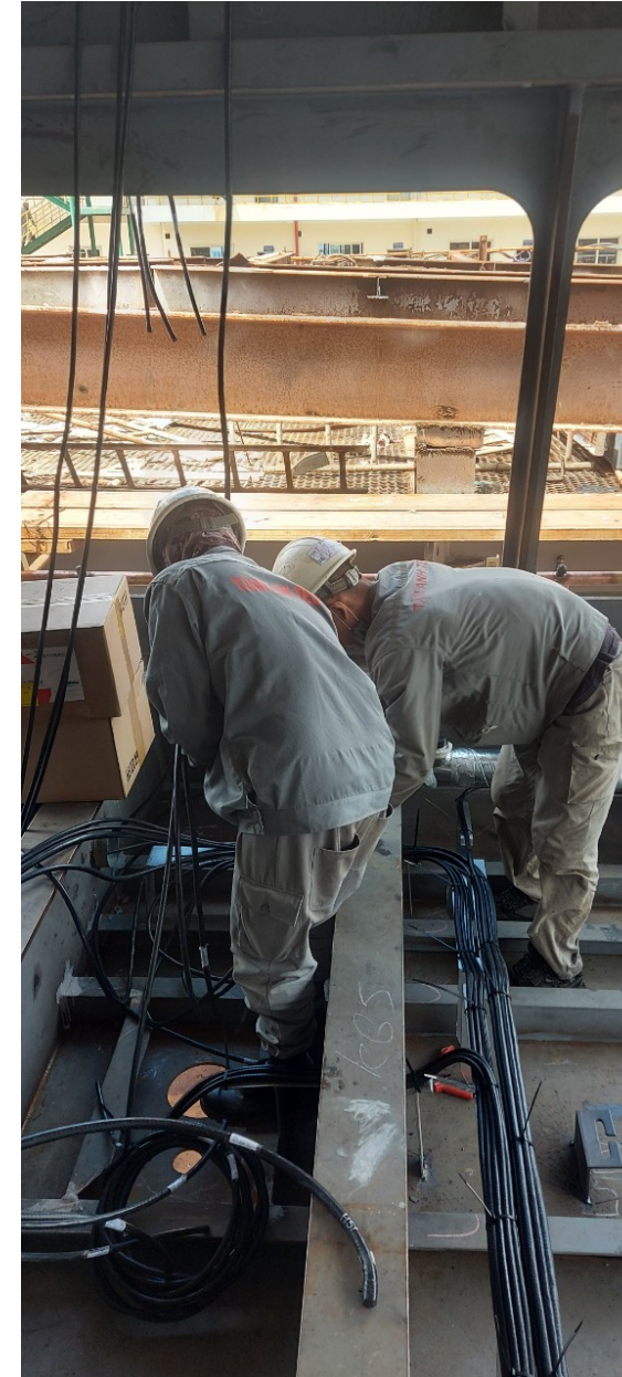
KÉO CÁP GIAI ĐOẠN BLOCK (PULLING CABLE AT PRE OUT STAGE)
