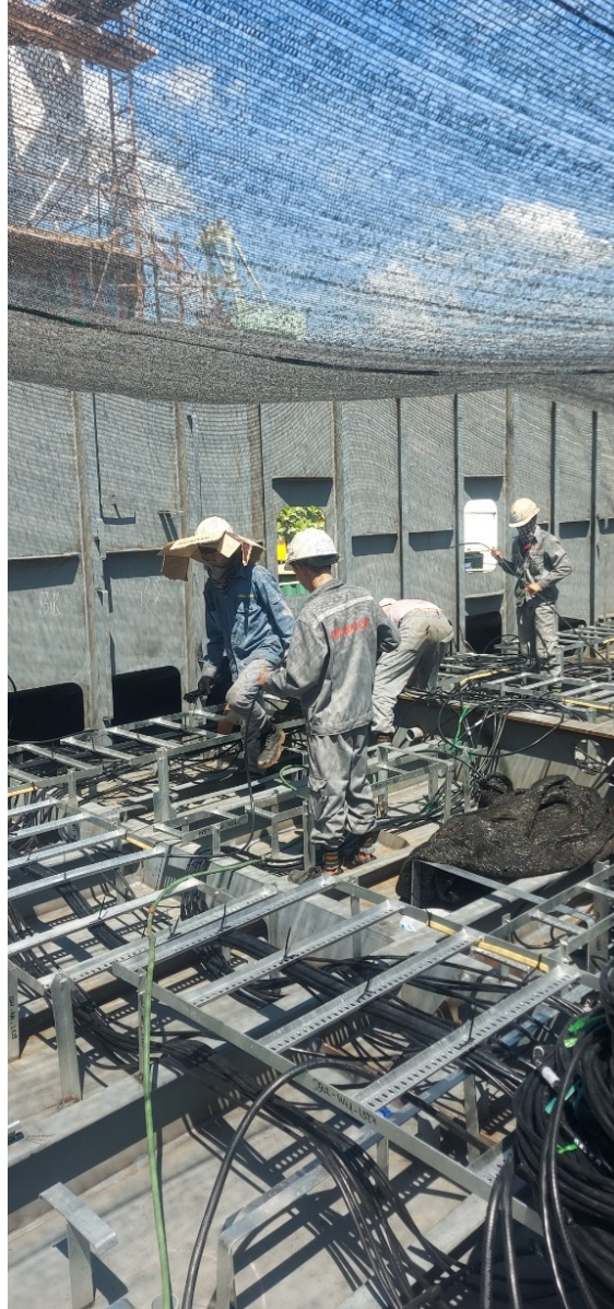
KÉO CÁP GIAI ĐOẠN BLOCK (PULLING CABLE AT PRE OUT STAGE)
