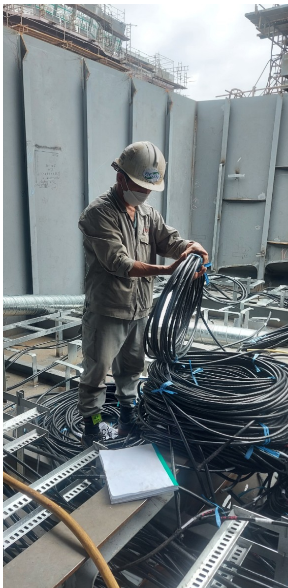
KÉO CÁP GIAI ĐOẠN BLOCK (PULLING CABLE AT PRE OUT STAGE)
